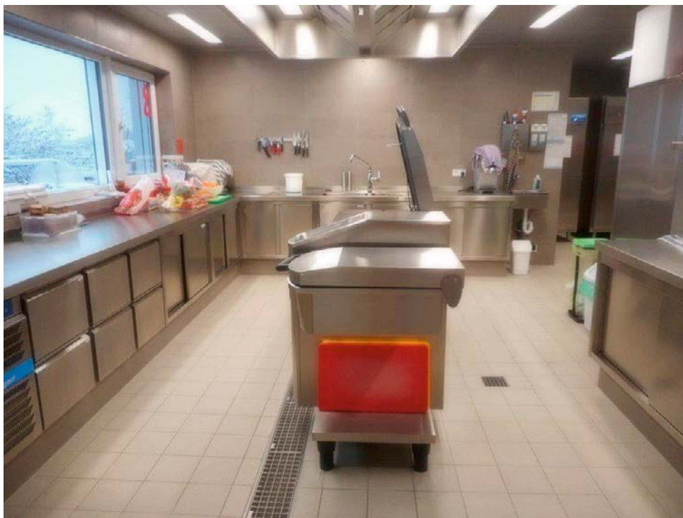
Abbildung 8: Gewerbliche Spülmaschine (Korbdurchschubmaschine) (Foto: Kath. Kindergarten St. Elisabeth, Salz)
