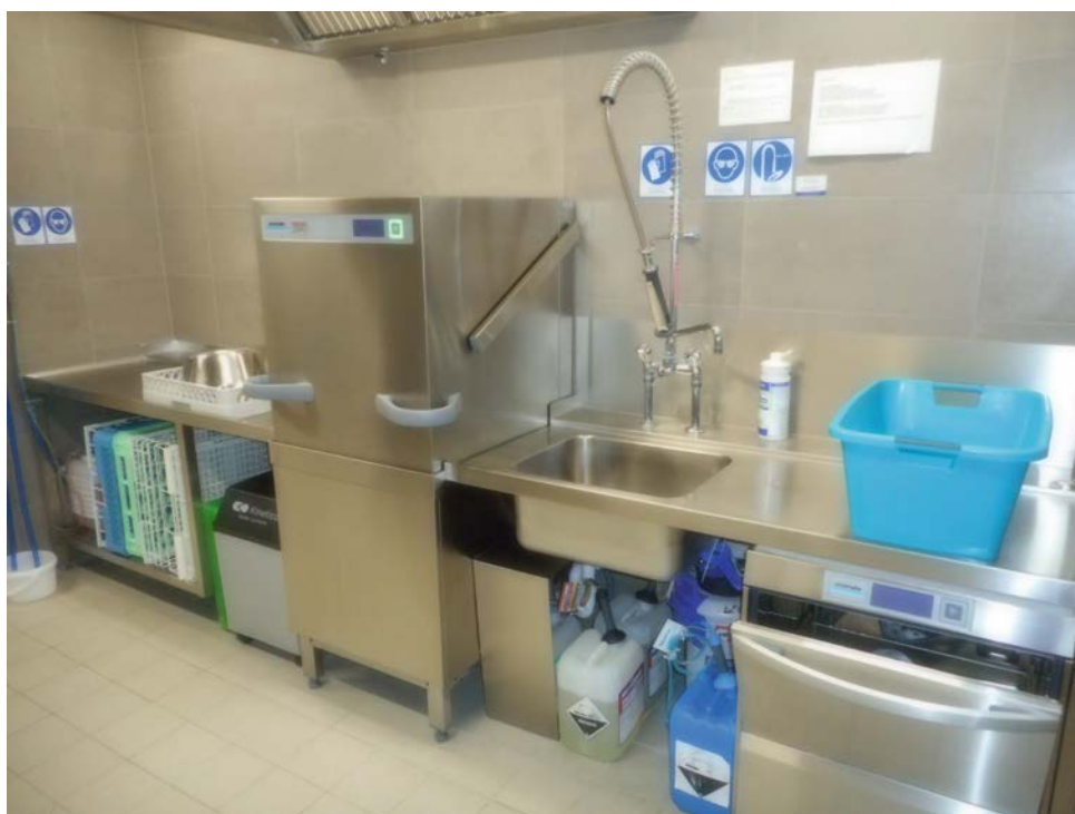
Abbildung 8: Gewerbliche Spülmaschine (Korbdurchschubmaschine) (Foto: Kath. Kindergarten St. Elisabeth, Salz)
